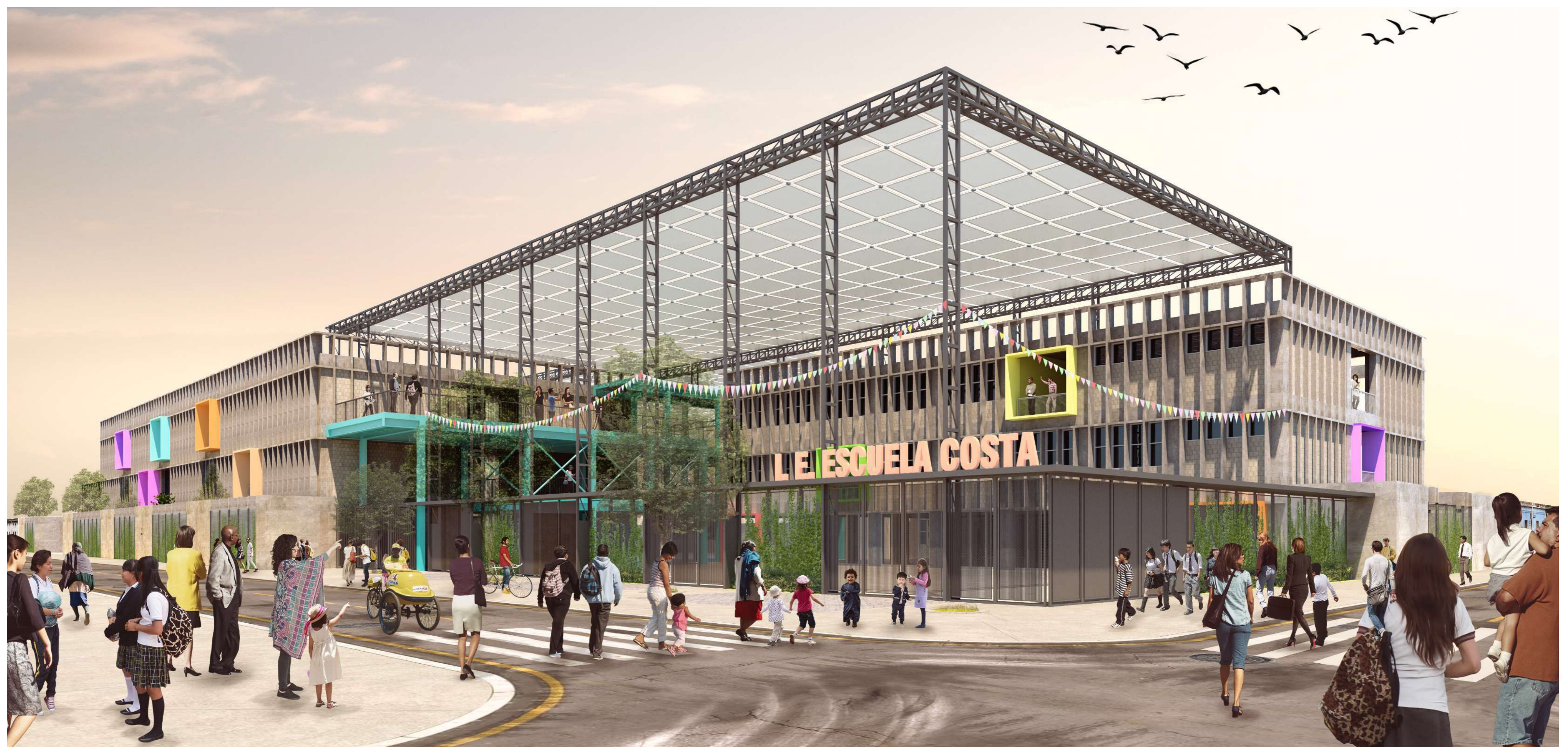
La ubicación preferente en el lote es N-S, para disminuir la luz solar directa a las aulas. Se proponen soluciones pasivas para resolver el asoleamiento en las aulas orientada E-O.
