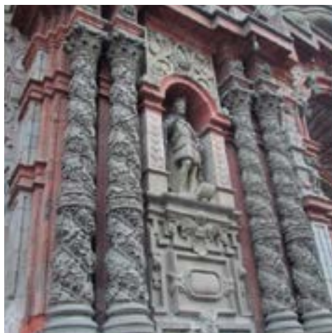
Fachada de la Iglesia de la Merced
